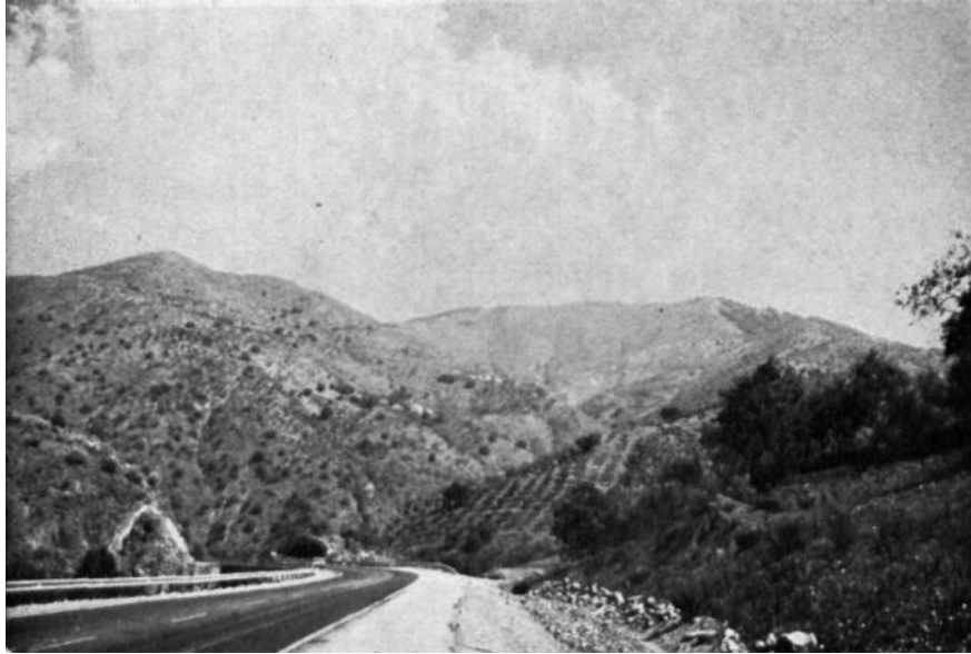
La carretera de "nuevo acceso" aparece trazada sobre el fondo del valle "Bético"
