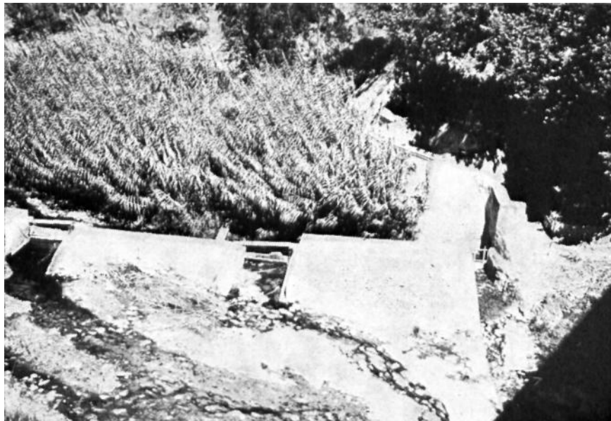
Pequeña obra para utilizar el escaso caudal del río en regadío de cultivos
